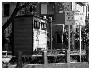
荒田公園トイレ設置完成
