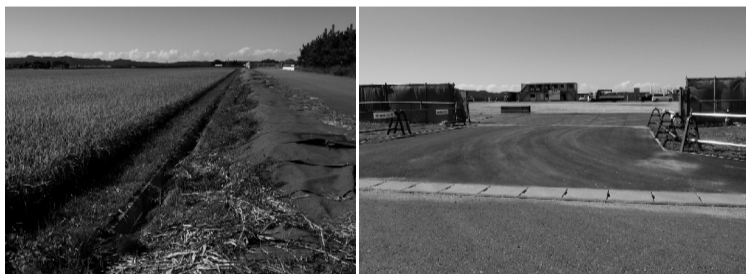
サイエンスパーク工事急ピッチ
