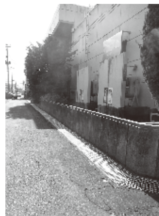
H29年9月 第二学区コミセン北側側溝グレーチング完成
