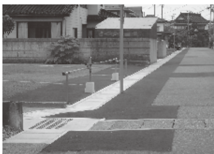
H29年6月 日出二丁目地内道路冠水防止工事完成
