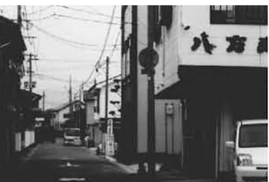
神明町の住民要望の側溝改修工事始まる
